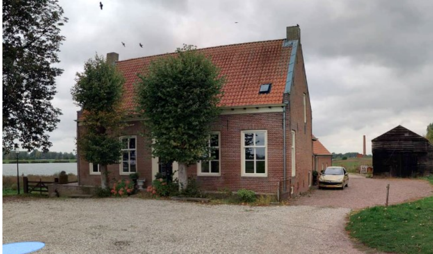
5. De Opslag 2 – Boerderij, dwarshuis met zadeldak
