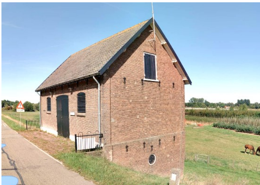
9. Grebbedijk 3, 3911 VH Rhenen – Dijkopslaghuis
